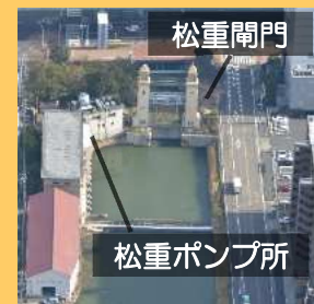
水質改善 (松重ポンプ所)
