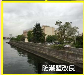
防潮壁の防災機能強化
