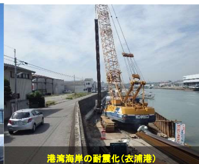
港湾海岸の耐震化(衣浦港)
