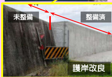
防潮壁の防災機能強化
