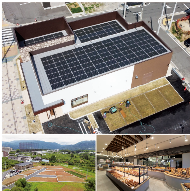
「パン屋SUNtoF」の屋上にはソーラーパネルを敷き詰めて店の電力の一部を賅っており(写真上)、店内には100種類以上のパンが次々と焼き立てで並べられます(写真右下)。当社は使用していない田畑などの土地の造成工事も手掛けており(写真左下)、将来的にはその土地に「電気屋さんがつくるお家」というコンセプトで家を建てて販売する計画も進めています。
